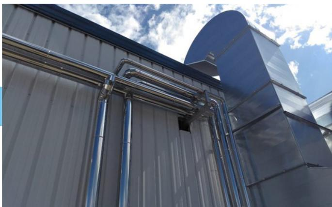
En 2019, Arce Clima llevó a cabo una instalación compuesta por un climatizador de 190kw, capaz de mover un volumen de aire de 30.000 m<sup>3</sup>/h. Todo ello, apoyado por un sistema de free-cooling que utiliza el aire frío del exterior. La instalación tuvo lugar en una sala de procesos PET de una central lechera, que tenía además algunas necesidades concretas a las que la empresa instaladora debía dar respuesta.
