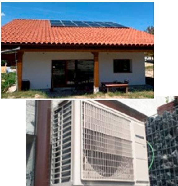
Lansolar ha sido el encargado de ejecutar en Amurrio (Araba), un sistema híbrido de aerotermia y energía solar fotovoltaica. La obra se ha llevado a cabo en una vivienda unifamiliar de nueva construcción con el objetivo de proveerla de un sistema de climatización altamente eficientes.
