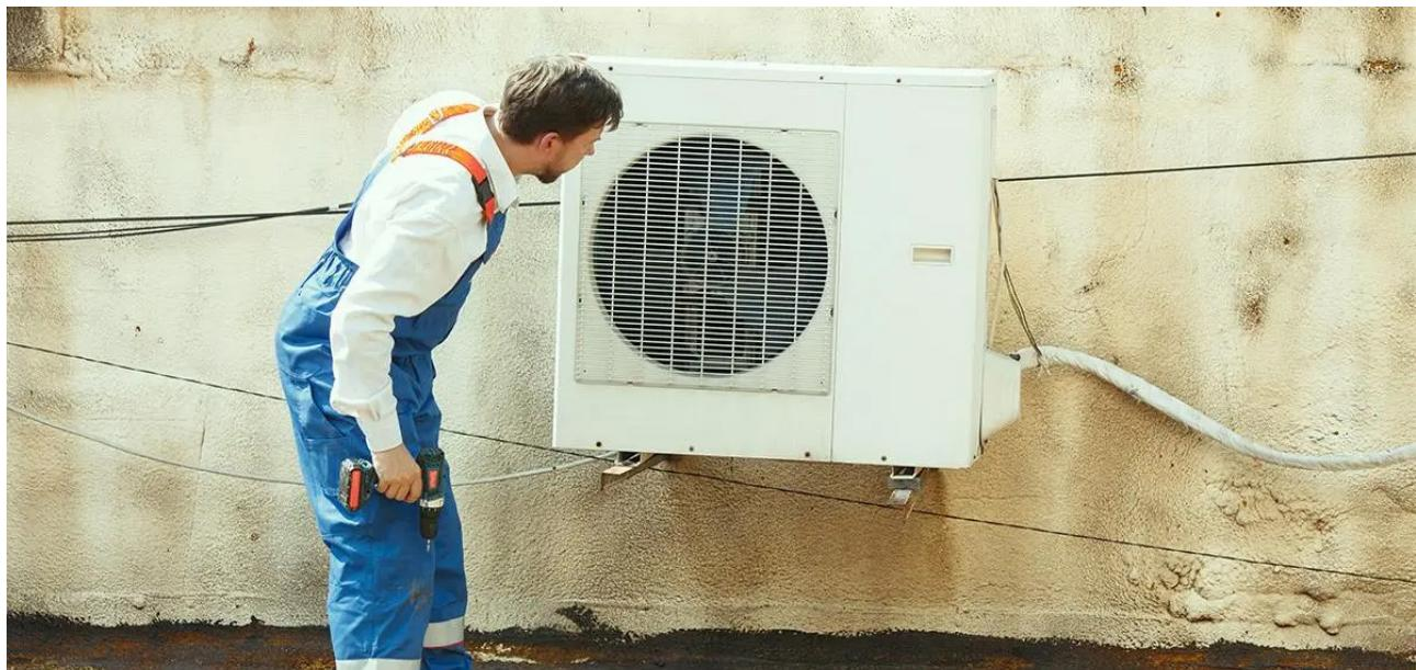
Evaluar las necesidades del inmueble es un paso previo imprescindible a la instalación de una bomba de calor. Hay que tener en cuenta las dimensiones del espacio a climatizar, el tipo de aislamiento de la edificación y su orientación. De esta forma se podrán calcular las necesidades caloríficas reales, para elegir así una bomba de calor con la potencia adecuada.
