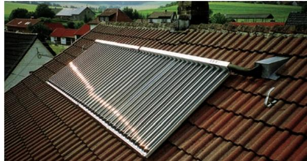
Fig. 52: Ejemplos de instalaciones – Colector de tubos de vacío
