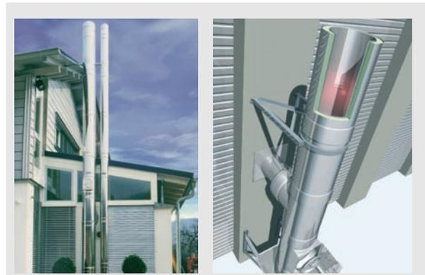
**Fig. 96: Sistemas de doble pared**
