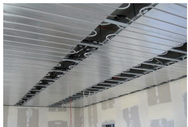
**Fig. 75: Doble función: calefacción y refrigeración en la zona del techo**
