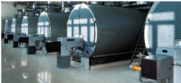
**Fig. 100: Sistema de calefacción consistente en siete generadores de agua caliente con una potencia total de 105 MW**
