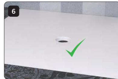
Presente el plato sobre la válvula, y asegúrese que descansa perfectamente sobre la junta de estanqueidad inferior.
