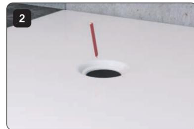
Escoja el modelo adecuado en función del orificio de salida del plato de ducha (Ø52, 62 ó 90 mm). Marque la posición de la válvula.
