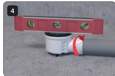
Nivele la válvula y fíjela a la tubería de salida. Puede encolar o introducir directamente el tubo en la salida equipada con junta, y apretar la tuerca.
