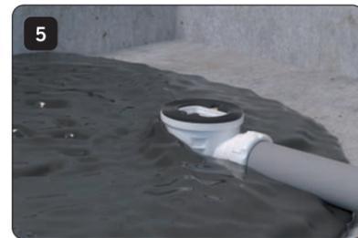
Compruebe que la conexión de la válvula con el tubo de evacuación no presenta ninguna fuga y rellene la base del plato de ducha de acuerdo con las instrucciones del fabricante.
