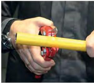
**Paso 1:** realizar un corte perpendicular al eje de la tubería multicapa GPF GAS.
