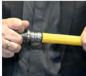
**Paso 2:** calibrar el interior del tubo y escariar interiormente 1 mm para diámetros de 16 a 25, y 2 mm para diámetro 32.
