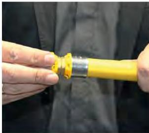
**Paso 3:** introducir el tubo en la pieza, comprobando a través de los orificios del anillo plástico que sujeta el casquillo de acero inoxidable que ha llegado al final.
