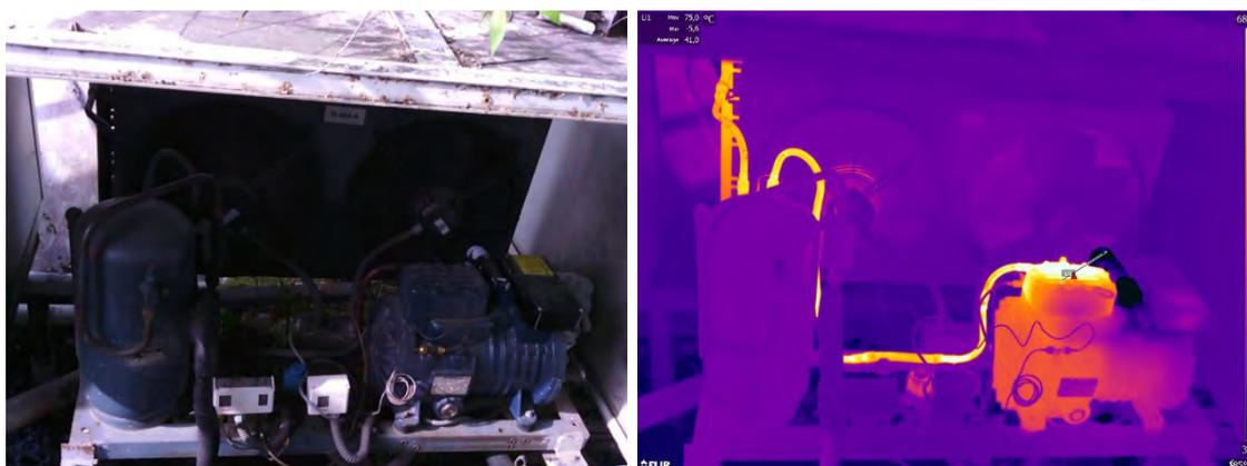
Foto 25 y 26: Máquinas de frío de las cámaras de frigoríficas de los alimentos
