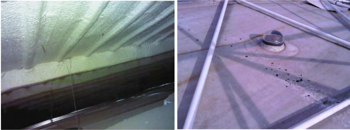
Foto 5 y 6: detalle del proyectado de espuma y una claraboya para la iluminación natural.
