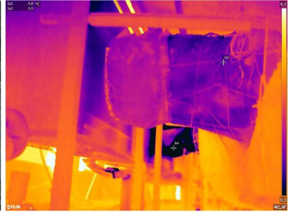
Foto 17 y 18: Vista lateral del climatizador y el tramo del conducto de impulsión de aire al interior del recinto.
