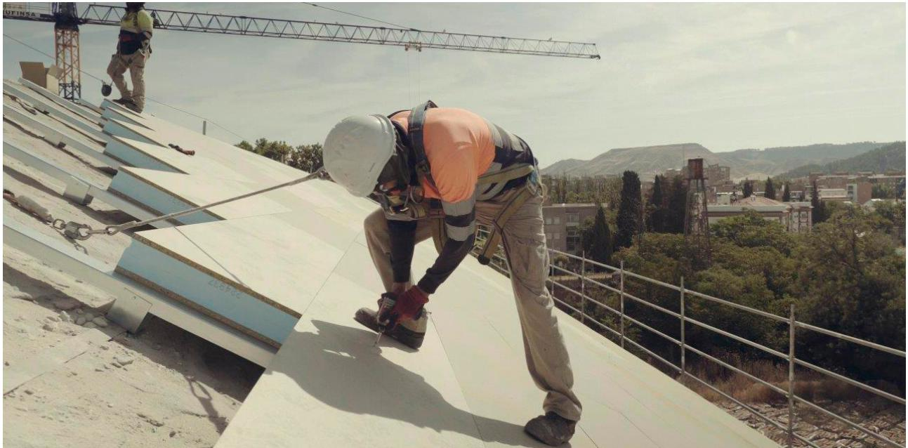
A las cubiertas inclinadas **se les conoce popularmente como tejados**. A diferencia de la cubierta plana, la cubierta inclinada presenta una pendiente mayor, de entre un 5% y un 60%. Su uso es generalizado en climas muy fríos con fuertes nevadas, lluvias abundantes o vientos fuertes. También suele ser habitual que la normativa urbanística obligue a construir con cubierta inclinada en centros históricos.
