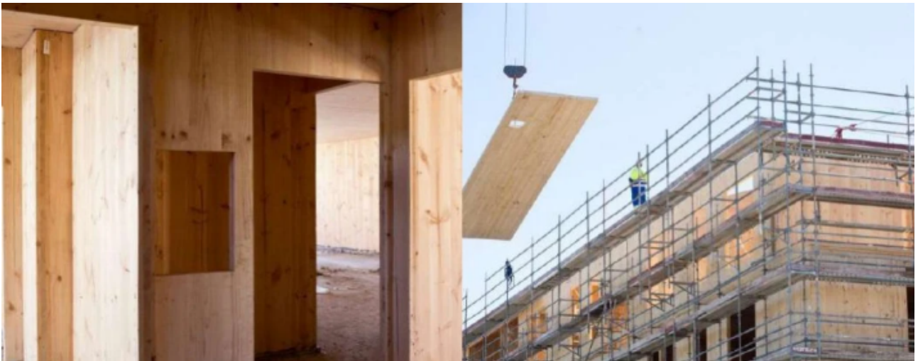
Sistema de paneles contralaminados de madera en Hondarribia (Gipuzkoa). Egoín.
