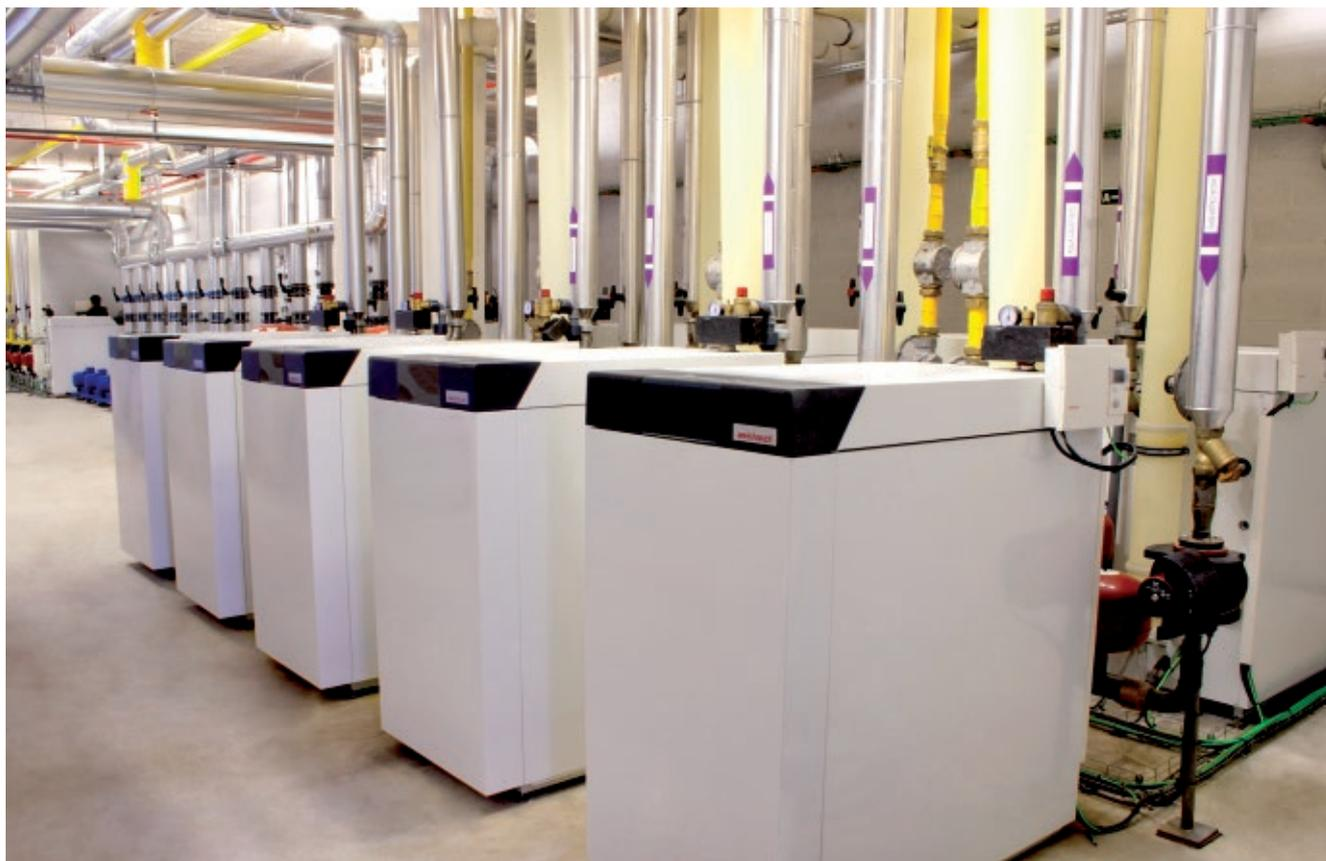
Instalación de 14 calderas WTC-GB-300 en cascada ubicada en Aoiz (Navarra)
