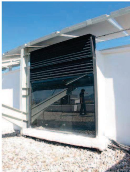
Foto 2. Captador de una de las chimeneas solares.
