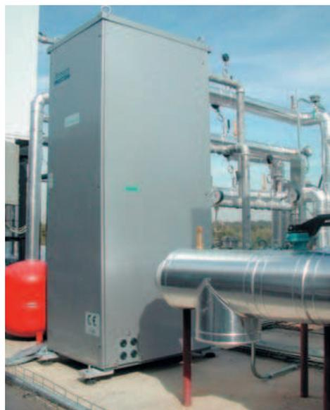
**Foto 2.** Planta enfriadora de agua por ciclo de absorción YAZAKI modelo WFC SC05.
