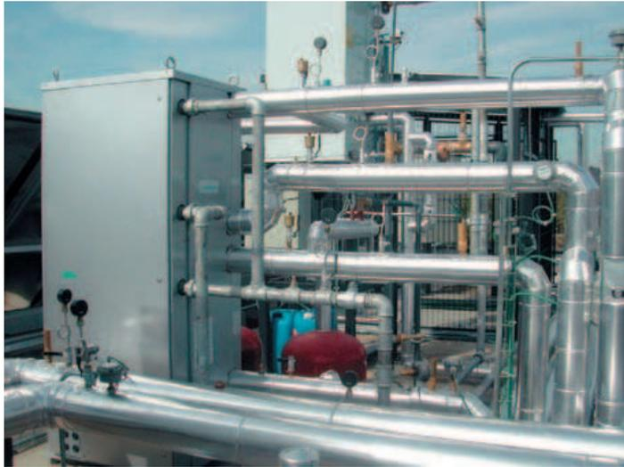
**Foto 1.** Planta enfriadora Yazaki, torre de enfriamiento y tuberías del circuito hidráulico.
