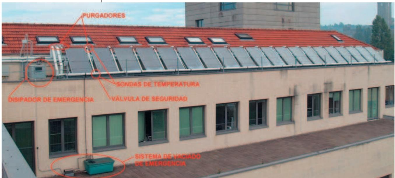
**Foto 1.** Campo de captadores solares de la instalación. Fuente: ARFRISOL.
