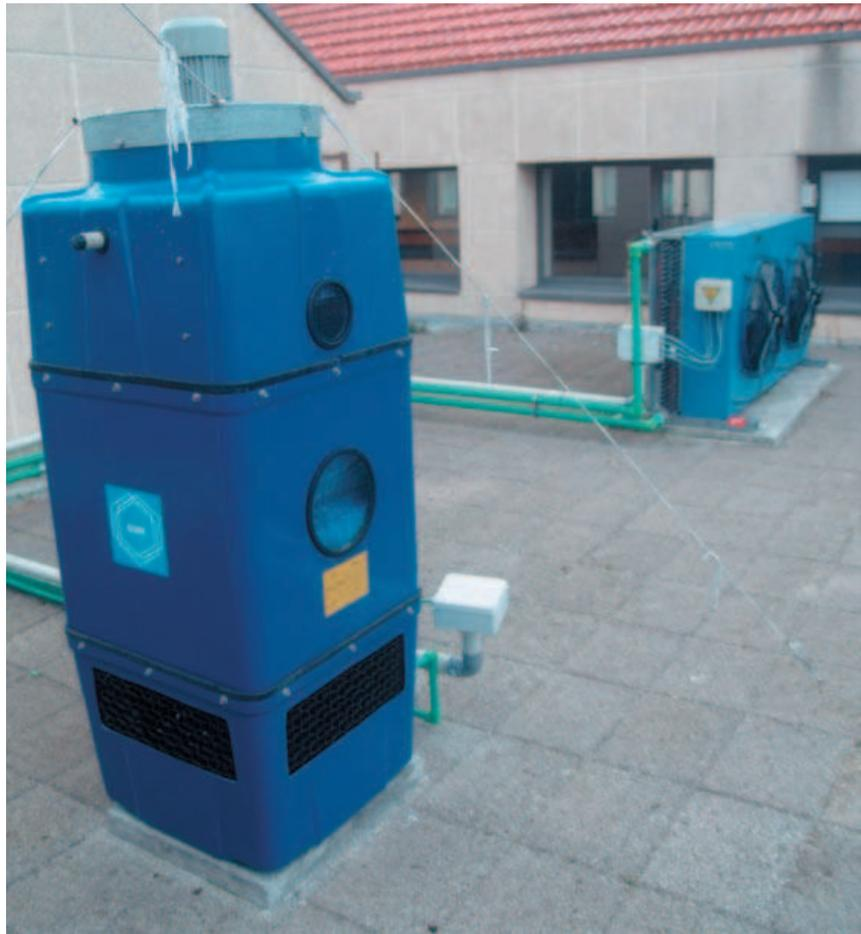
**Foto 3.** Sistemas de disipación. Fuente:ARFRISOL.
