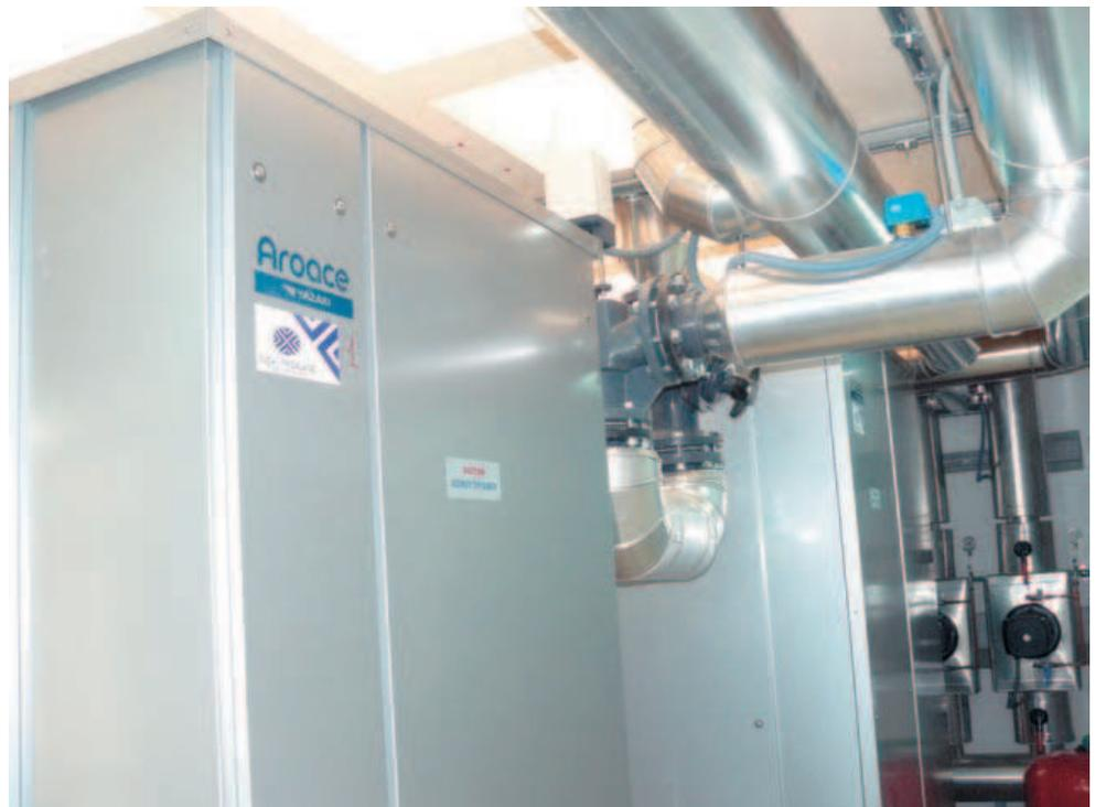
**Foto 2.** Las dos plantas enfriadoras Yazaki situadas en la sala de máquinas.
