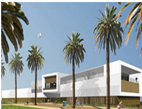
Instalación de Climatización y Ventilación en un edificio terciario.
