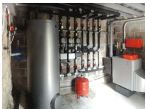
Instalación para calefacción de caldera de Gasoil en edificio de Apartamentos
