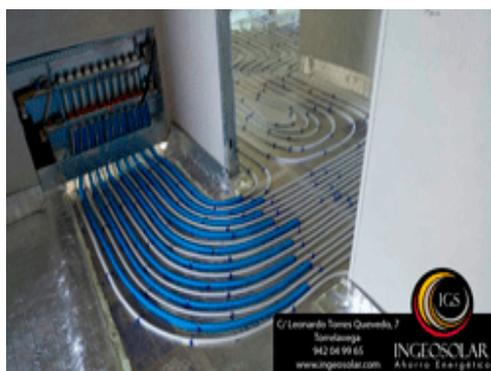
Instalación de aerotermia y agua caliente sanitaria con suelo radiante en Cantabria
