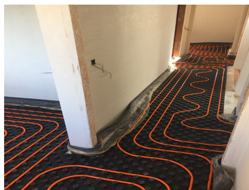
Instalación de suelo radiante con aerotermia en una vivienda unifamiliar
