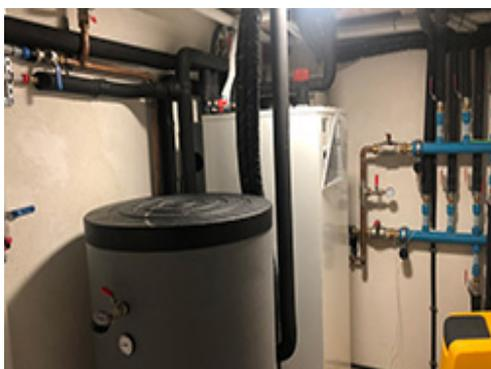
Instalación de aerotermia con techo radiante y control de humedad en una vivienda
